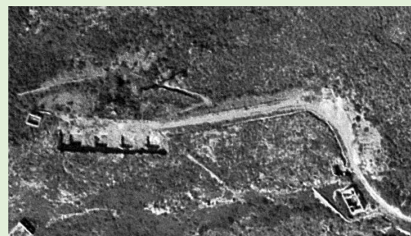
Imagen aérea de 1973 donde todavía son visibles los 4 pozos de pieza construidos, y de la explanada de fuego observada desde su retaguardia.
