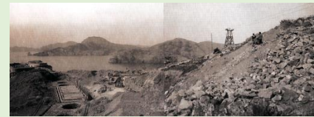
Imagen de las obras de fortificación y artillado de Trincabotijas Alta. Se observan sobre polines parte de los tubos de obús de 24cm esperando su artillado. En la parte superior, el Castillo de San Julián.
