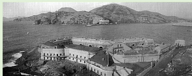
Imagen de la actual batería recién terminada su construcción.
